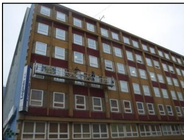
Façade Letna 45 voor renovatie
