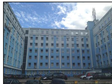
Façade Letna 45 na renovatie
